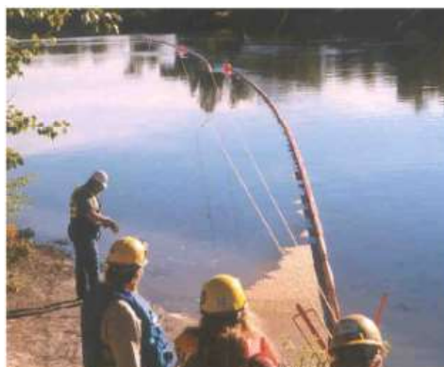
Colocación de barreiras para desviar o hidrocarburo ata unha zona de recolección
