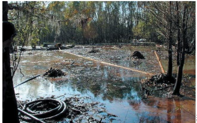
Los hidrocarburos atrapados en aguas tranquilas se pueden guiar físicamente hacia un sitio de desnatado por medio de rociar agua. El objetivo es empujar los hidrocarburos hacia barreras de contención y skimmers. Se debe tener cuidado de no mezclar los hidrocarburos en la columna de agua, donde pueden entrar en contacto y adherirse a sedimentos y, por lo tanto, volverse más difícil de eliminar.
