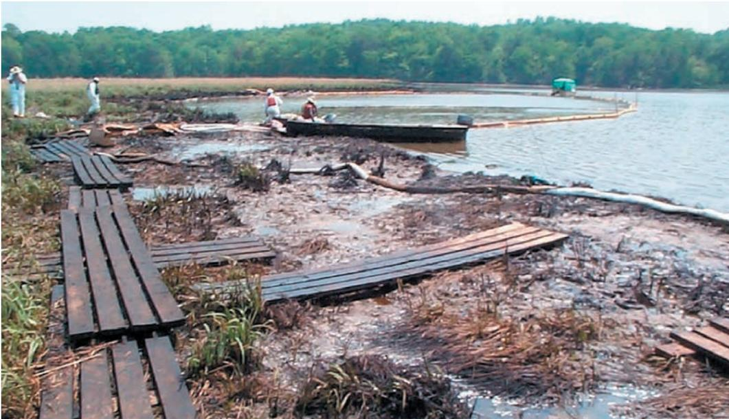
*Remoción de hidrocarburos de un humedal contaminado con combustóleo pesado; para reducir el pisoteo se utilizan plataformas.*
